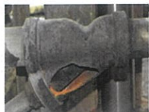
รูปที่ 1 Y-strainer แบบเหล็กหล่อ ติดตั้งอยู่ในท่อส่งของเหลว
