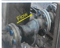
รูปที่ 1 Y-strainer แบบเหล็กหล่อ ติดตั้งอยู่ในท่อส่งของเหลว
